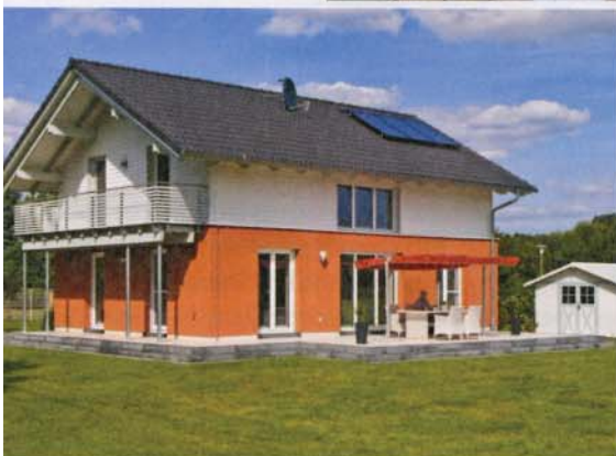
|| Die horizontale Gliederung der Fassade wird durch die Farbwahl zusätzlich betont und unterstreicht in diesem Fall die kombinierte Bauweise.
