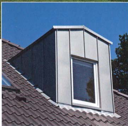
Markante Satteldachgauben prägen die Dachlandschaft des Bungalows mit ausgebautem Dachgeschoss.
