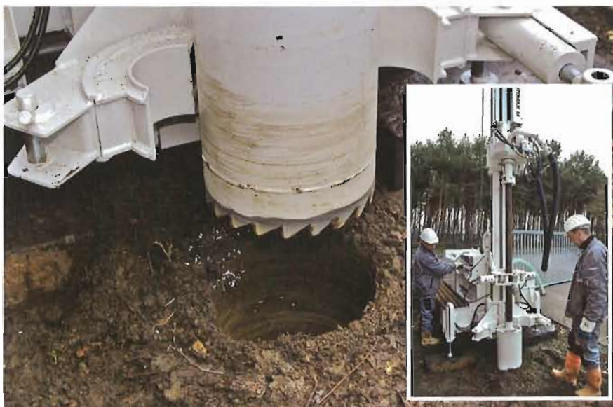
Bild 4.3: Experten bringen die Bohrungen für die Erdsonde einer Wärmepumpe ein
