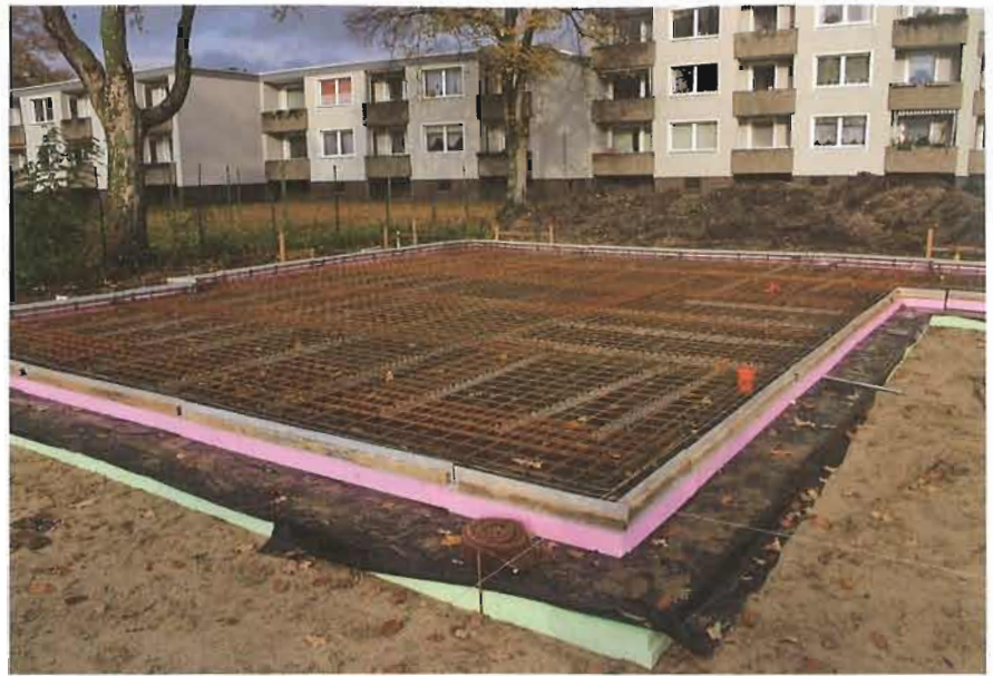
Bild 4.2: Unterseitig gedämmte Fundamentplatte eines Wohngebäudes
