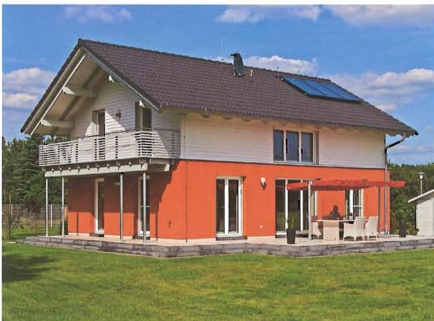
Bild 4.1: „Nachhaltiges“ neues Wohngebäude eines großen deutschen Bauträgers
