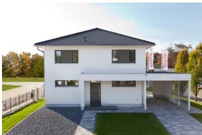
Heinz von Heiden_Musterhaus Köpenick Eingang
